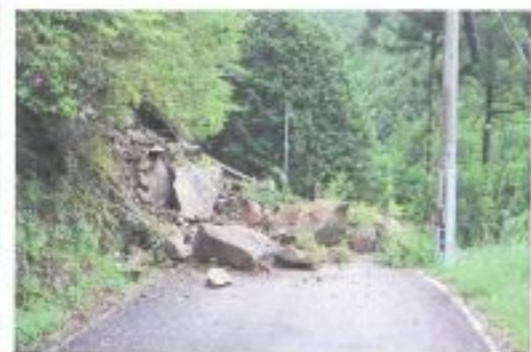
土砂崩れにより通行止めが頻発 (県土の約8割が山地部)
