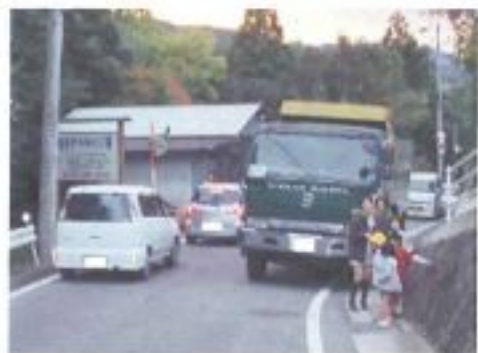
通学路に歩道がなく非常に危険
